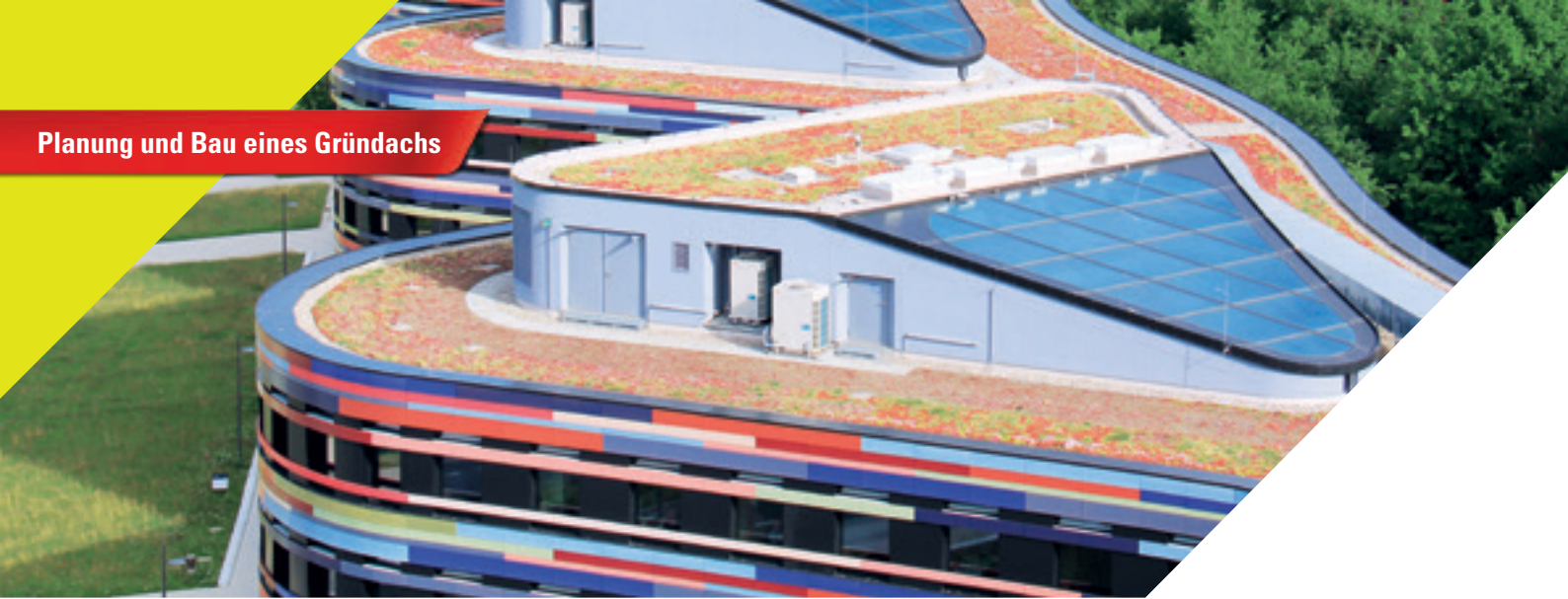
Das extensive Gründach der Behörde für Umwelt und Energie.
