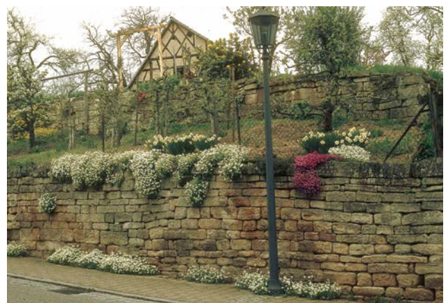
Eine Stützmauer terrassiert das Gelände. Bepflanzung kann sich auch in engsten Fugen am Fuß der Mauer etablieren. Der heimische Sandstein unterstreicht die Einzigartigkeit des Ortes. (© HR)
