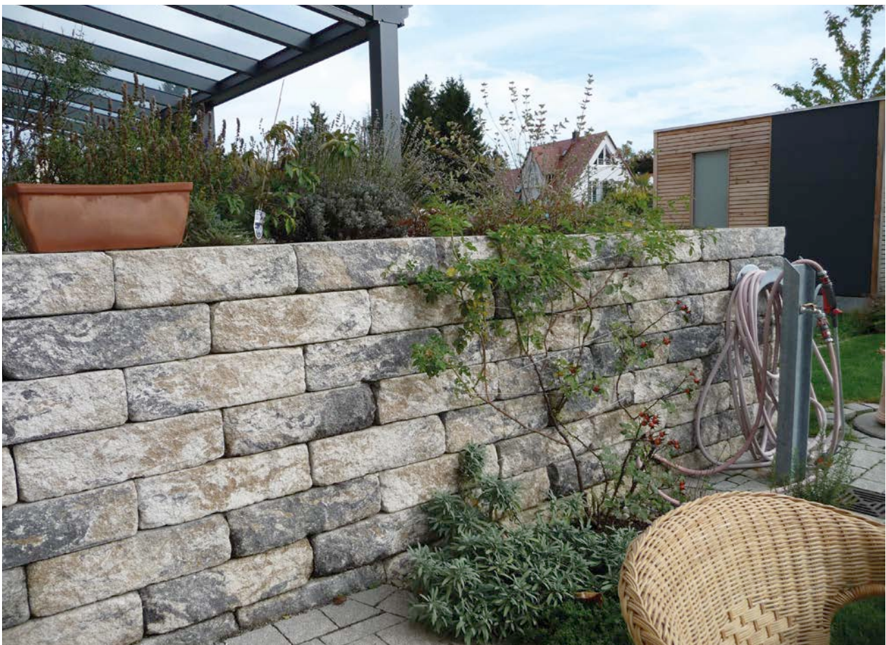
Eine Mauer aus Systemsteinen ist vergleichsweise einfach zu errichten. Bei einer Bepflanzung der Mauerkrone sollte die Breite der Mauer 60 cm deutlich überschreiten. (© HR)
