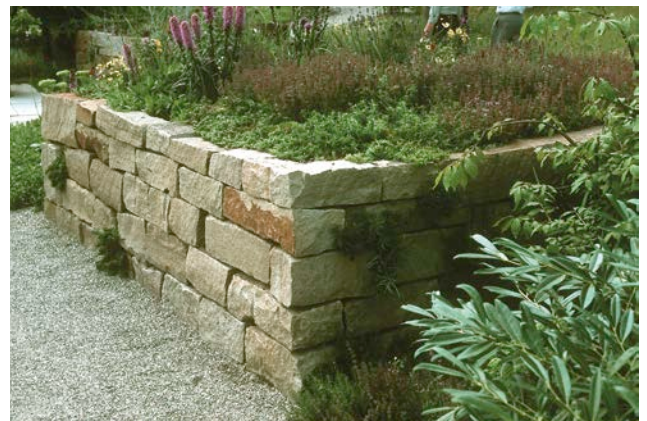
Eine Bauhöhe bis etwa Tischhöhe (hier 75 cm) dürfte keine statischen Probleme bereiten, zumal es keinen drückenden Hang gibt: eine attraktive Lösung für ein Hochbeet. (© HR)
