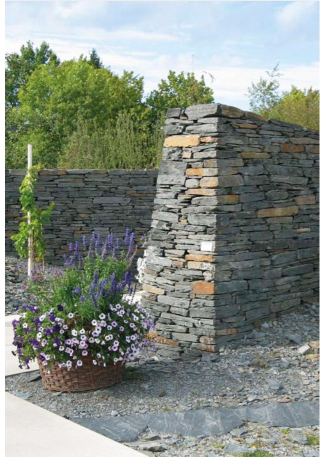
Freistehende Trockenmauern stellen höchste Ansprüche an die Statik und ihre Erbauer. Im Zweifelsfall ist professionelle Hilfe in Anspruch zu nehmen. (© HR)
