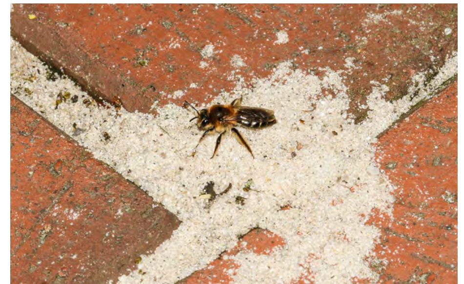
Durch breitere Fugen zwischen den Pflasterklinkern erhält diese Bärtige Sandbiene ( Andrena barbilabris ) Zugang zum sandigen Untergrund.
