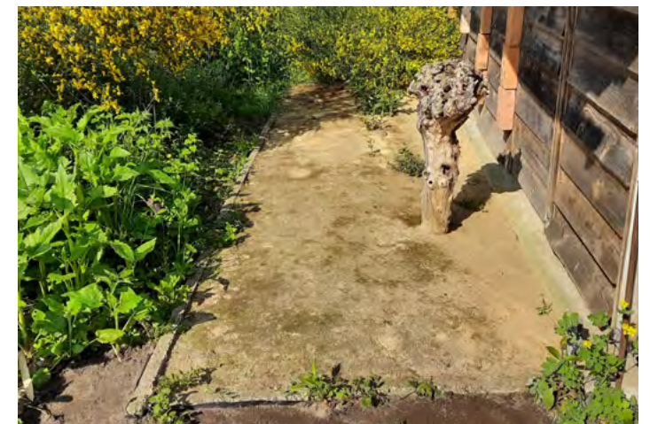
Schritt wurde in die Grube Feinsand eingefüllt. Rechts: Zwei Jahre nach dem Bau haben sich Algen und kleine Moose angesiedelt und den Sand befestigt.
