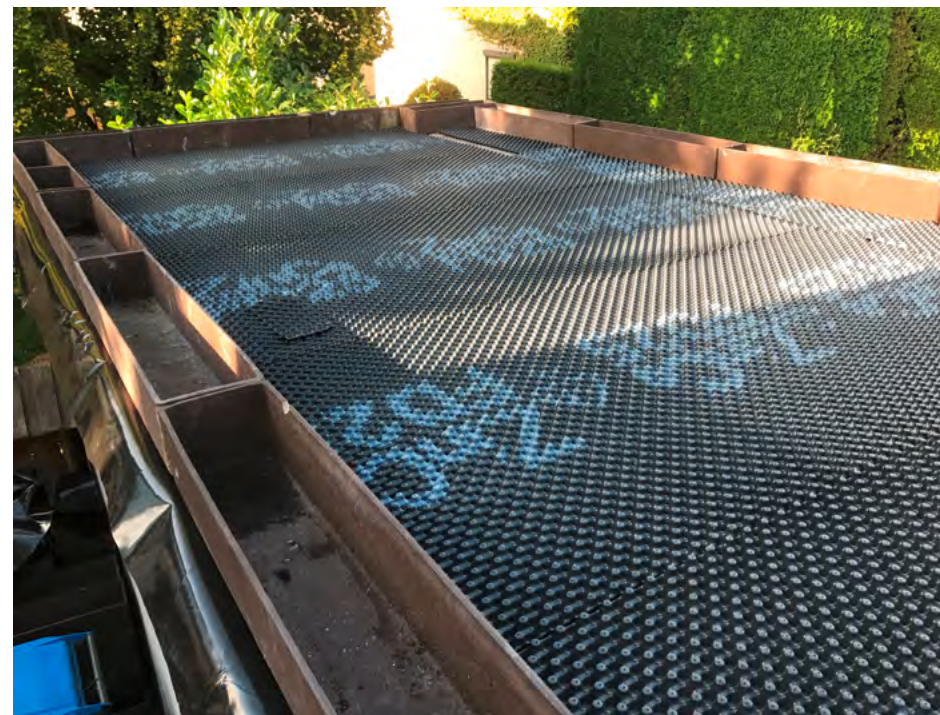
Schichten von unten nach oben: Dachhaut, Wurzelschutzfolie, Schutzvlies, Noppenfolie, Filtervlies, Substrat oder Dämmmatte. [alle Fotos Frank Reh]
