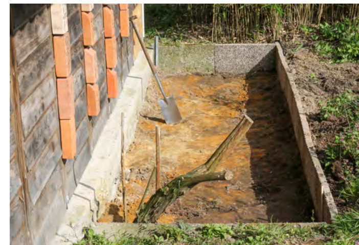
Links: Für dieses Sandbeet wurde der ursprüngliche Boden 50 cm tief entfernt. Damit keine Pflanzen aus den umliegenden Beeten in die Sandfläche einwandern, wurden alte Betonplatten als Wurzelsperre eingebaut. Im nächsten
