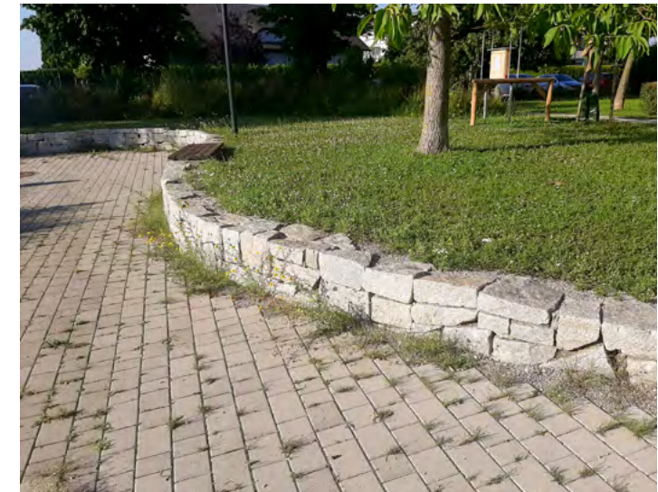
Vom Planer kopiert: Der Rand des Pflasters wurde mit Bruchschotter verfüllt und mit Spezialsaatgut eingesät.
