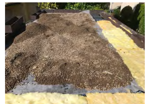
Schichten von unten nach oben: Dachhaut, Wurzelschutzfolie, Schutzvlies, Noppenfolie, Filtervlies, Substrat oder Dämmmatte. [alle Fotos Frank Reh]
