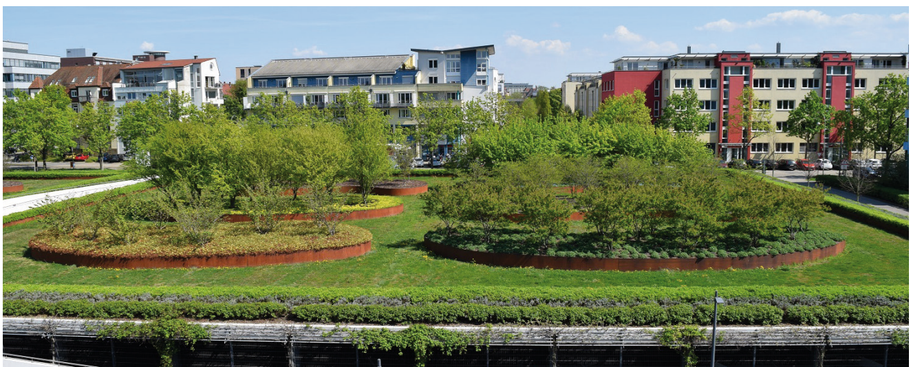
Dachbegrünung Parkhaus, Karlsruhe © Bundesverband Gebäudegrün e. V.
