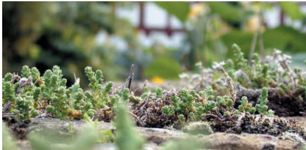
Vor allem der Mauerpfeffer ist der Bestandteil dieser Dachbegrünung
