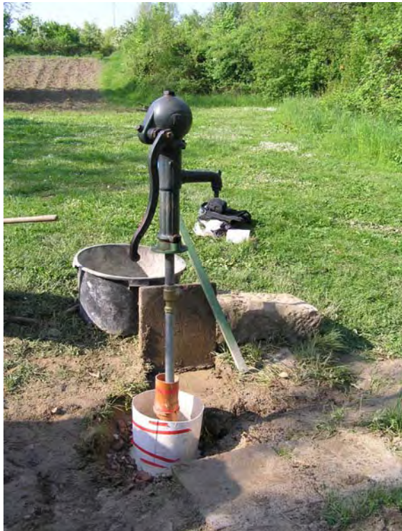
Einbau einer Handschwengelpumpe
