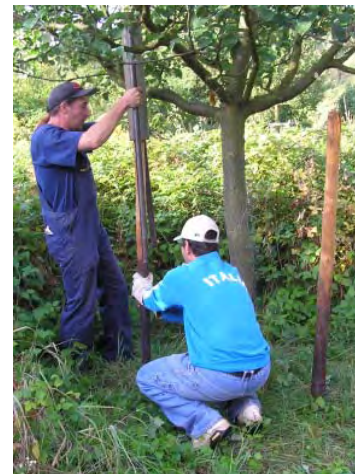
Schlagkatze im Einsatz
